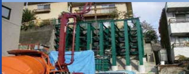
老朽化擁壁補強工事
