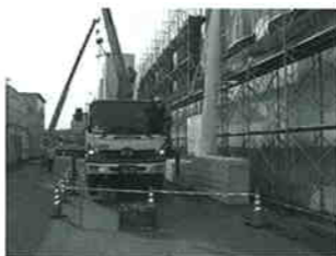
平成19年度水再生センターの工事
